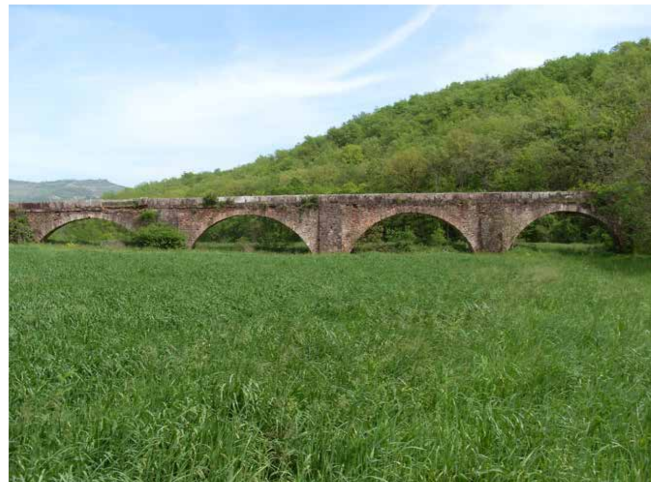
Aqueduc de Rayssac entre les communes de Montlaur et de Vabres-l'Abbaye
