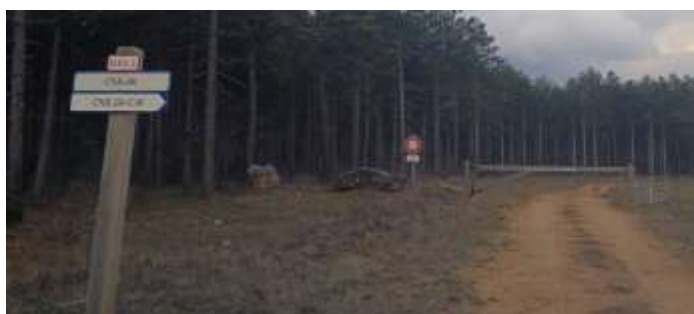
Figure 27 : Modèle de signalisation d'entrée sur une piste DFCI (Panneau B0, barrière, et numérotation de piste)
