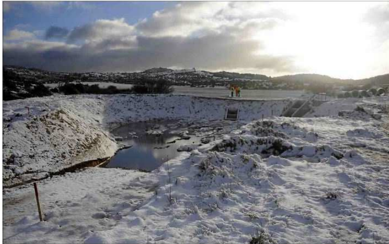
■ Le bassin de décantation numéro 44 a été refait en 2016. Même s'il est aux normes, il n'est pas fiable à 100 %. ARCHIVES V. D.
