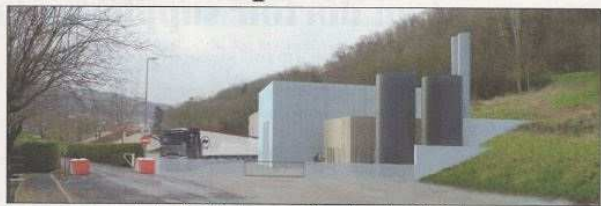
La chaufferie à bois sera construite sur le parking Saint-Roch, derrière le cinéma (© Causses Energia).
