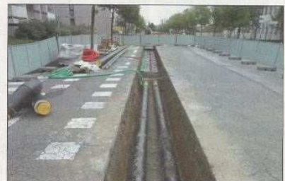
Un exemple de tranchées qui seront creusées dans la ville lors des travaux (© Causses Energia).
