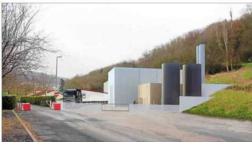
■ La future chaufferie sera implantée sur le parking Saint-Roch.
