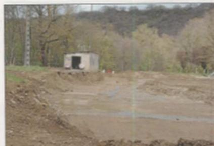
Le bâtiment que l'on voit sur la photo correspond aux anciens vestiaires du stade qui vont être détruits ainsi que l'on peut mesurer le décaissement effectué et les milliers de m<sup>3</sup> de terre qui ont été enlevés pour réaliser le premier palier afin de permettre un meilleur écoulement de l'eau en cas de crue.
