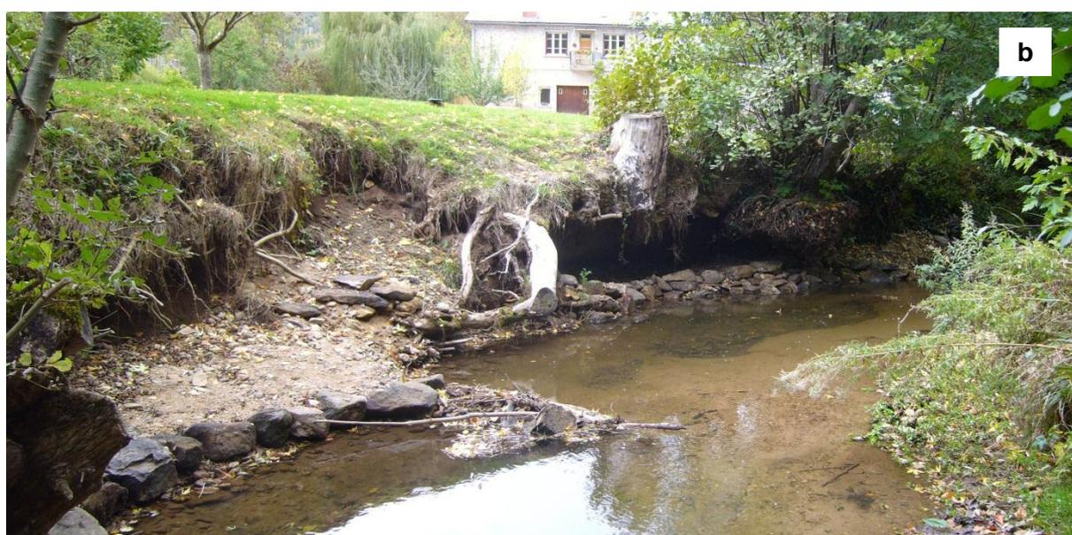
**Figure 23 : incision régressive en amont qui entraîne et un affouillement de la passerelle en rive gauche (a) et une érosion de la berge en rive droite (b)**
