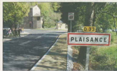
Les travaux d'aménagement de la traversée du village ont coûté 730.000 euros TTC financé à 70 % par des subventions publiques.
