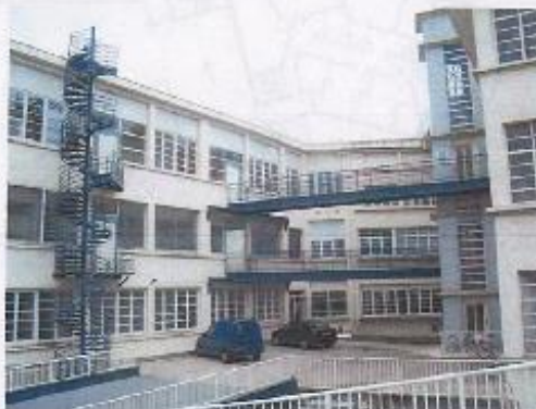
Photo 2 : Vue des façades 'Nord' depuis le Niveau 1
