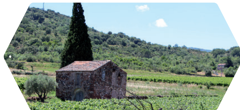
ANCIEN BÂTIMENT AGRICOLE
