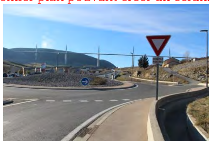
Perspective est/ouest sur le Viaduc de Millau depuis le rond-point du centre commercial.
