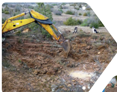
2 - Creusement manuel et mise en forme avec des paliers de profondeur
