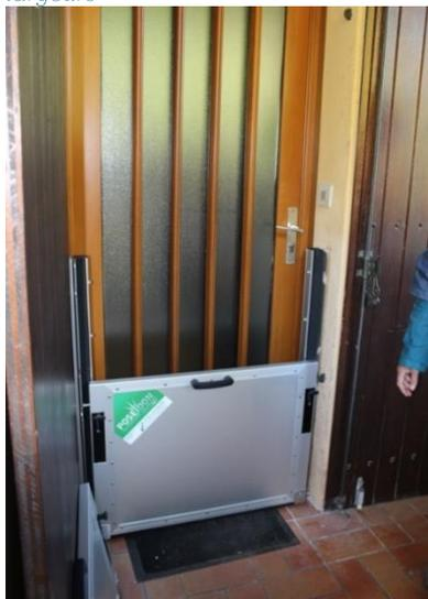
*Modèle MODUL pour les grandes largeurs : les matériaux sont légers et sont facilement manipulables ...*
