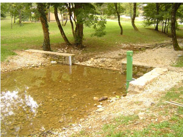
La **source d'Urugne** est une source ayant un réseau de conduits se développant au voisinage de l'exutoire. Le système est peu inertiel, avec un effet mémoire de l'ordre d'une semaine. C'est un système bien karstifié, possédant un volume de réserves relativement important avec quelques **2 millions de m<sup>3</sup>**. L'exploitation actuelle par pompage au niveau du champ captant est tout à fait appropriée.
