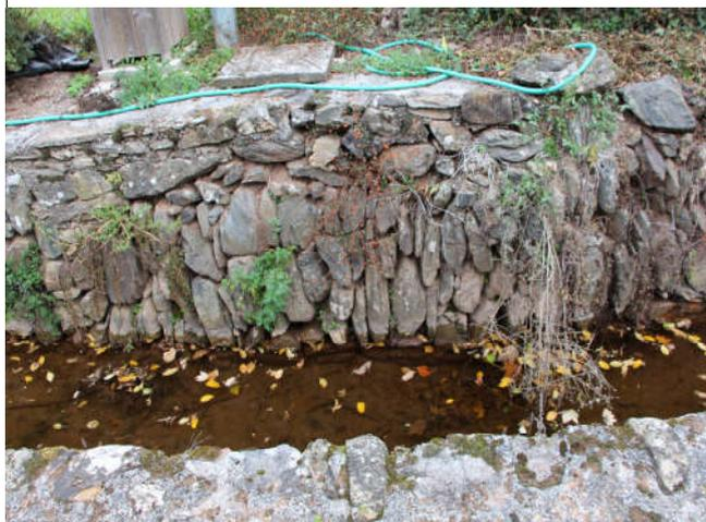
**Canal** : tine, béal, conduit de profil en U pour détourner un cours d'eau en amont d'une chaussée et alimenter un réservoir, un moulin ou irriguer des parcelles. En aval d'un moulin il ramène l'eau au ruisseau ou à la rivière.
