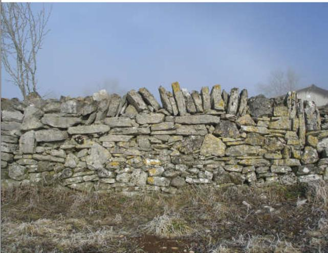
**Couronnement** : Clouque. Pierres posées de chant pour bloquer les deux parements d'un mur de clôture ou de soutènement en pierre sèches. Elles jouent le rôle de boutisse en reliant les deux faces du mur.
