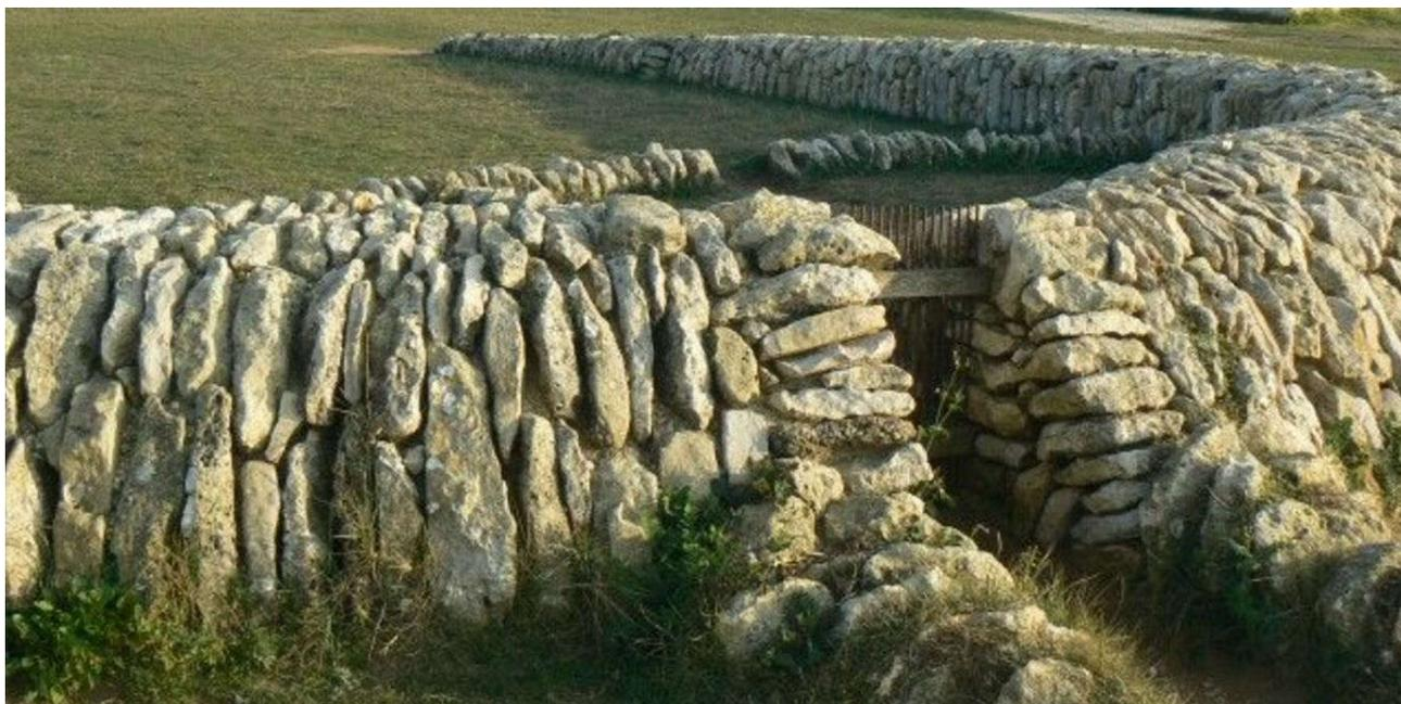
Écluse à poisson de l'île de Ré réalisée en calcaire clavé (capture d'écran)
