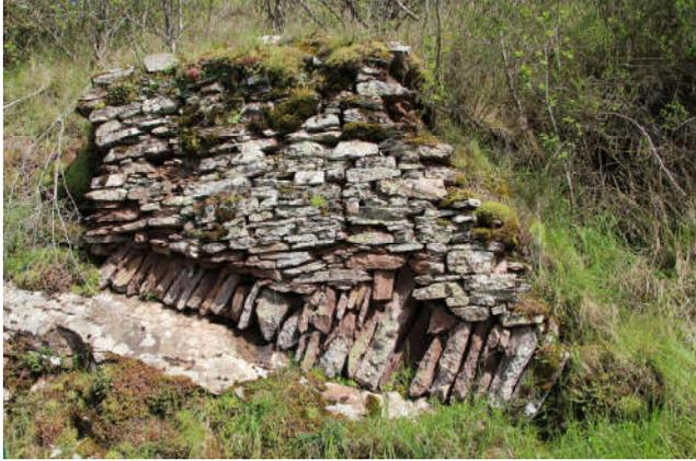
**Fondation de soutènement :** Pierres de chant utilisées pour constituer les fondations d'un mur sur un pendage rocheux en dévers.
