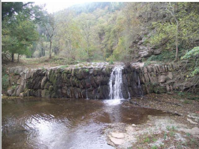
**Chaussée** : Seuil réalisé en pierres de chant pour alimenter un canal d'irrigation ou un moulin.
